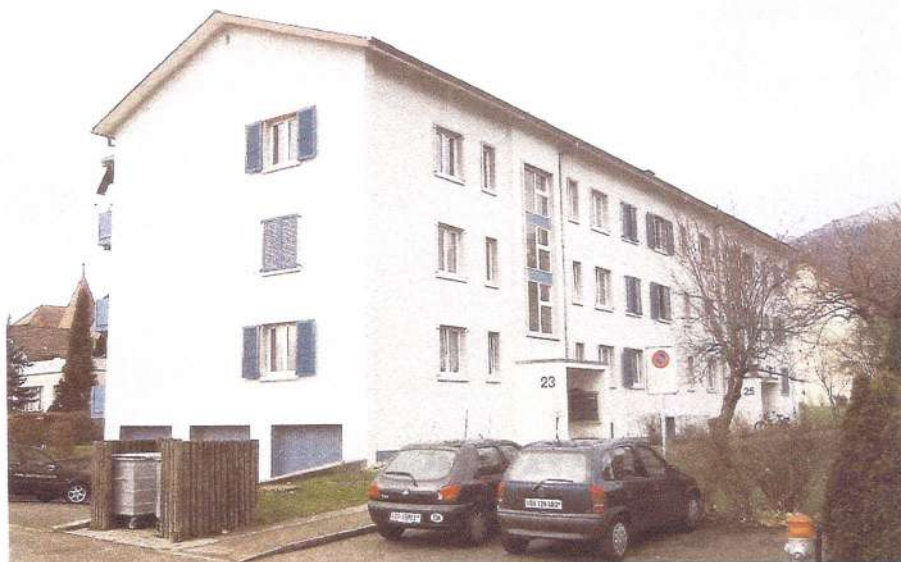
Ansicht von Osten
