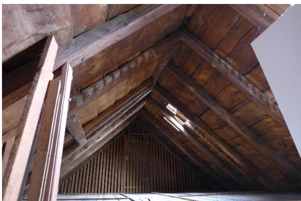
Charpente et lambris d'origine en bon état
